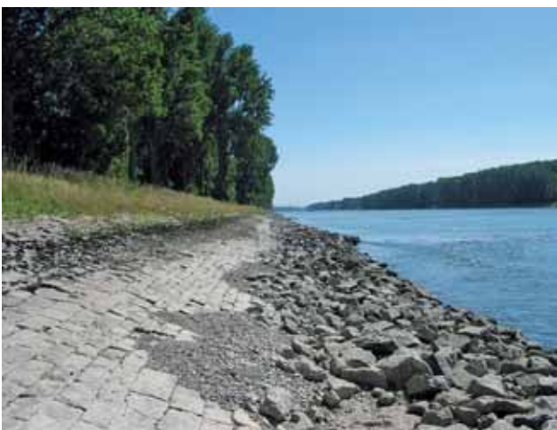
Abb. 30: Festlegen der Ufer im harten Steinverbau.
