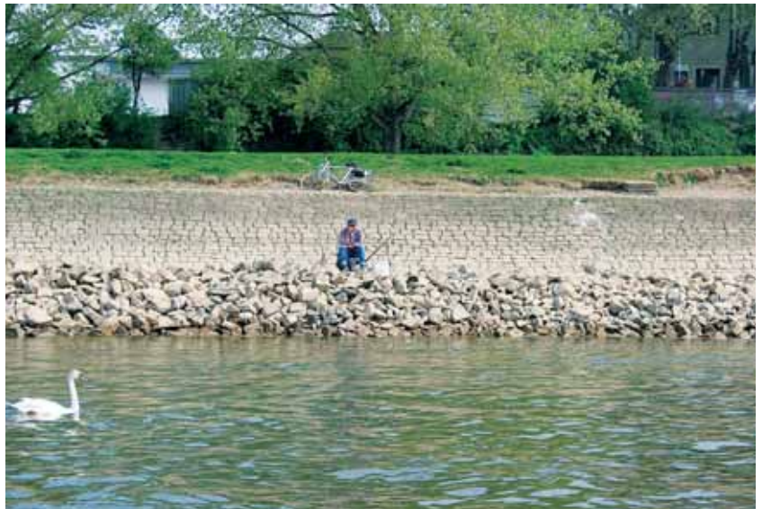
Abb. 46: Ausgebautes Neckarufer mit geringer Attraktionswirkung für Fische und Fischerei
