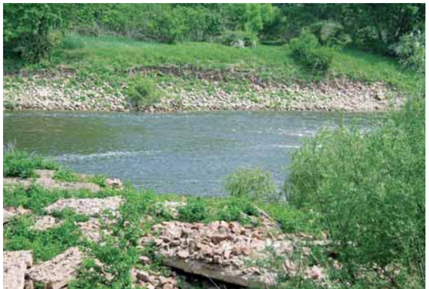
Abb. 44: Ausleitungsstrecke des Wehrarms Wieblingen mit unzureichendem Mindestabfluss
