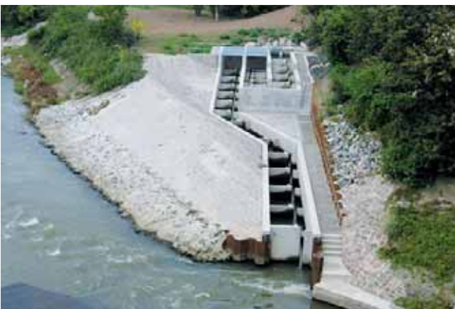
Abb. 12: Ehemaliger (oben) und neuer, im Jahr 2005 in Betrieb genommener Fischpass am Wehr Ladenburg
