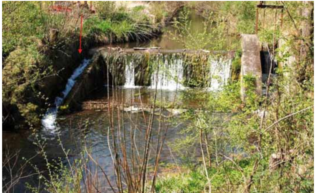
Abb. 47: Die Wehranlage im Kirbach, ca. 200 m unterhalb der Befischungsstrecke K1, mit der nicht funktionsfähigen Fischtreppe (s. Pfeil).
